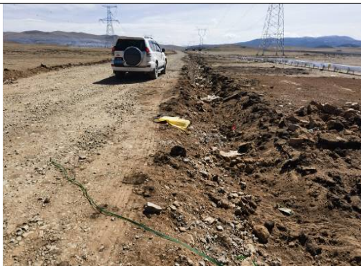
进场道路及排水沟
